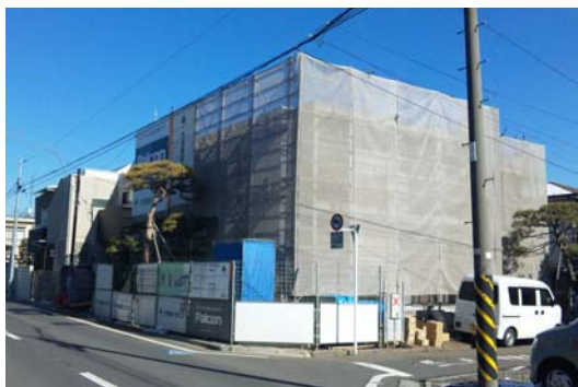
新築住宅の測定依頼が増加（上） 区議団で使用している測定器（右）
