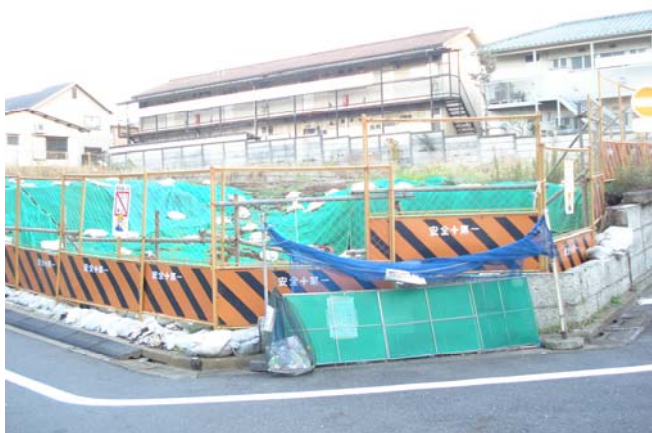
上井草2丁目の建設予定地
