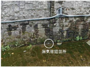
白子川護岸の水抜き孔や目地を通じ発生
