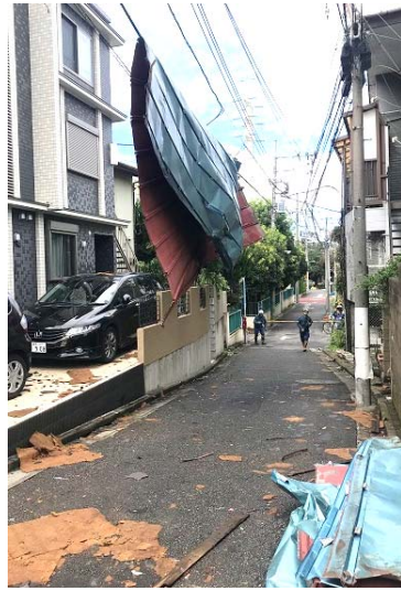
高円寺では住宅の屋根が飛ばされ、一部が電線にぶら下がる状況となった。
