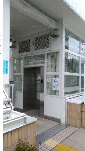
井荻駅北側エレベーター
