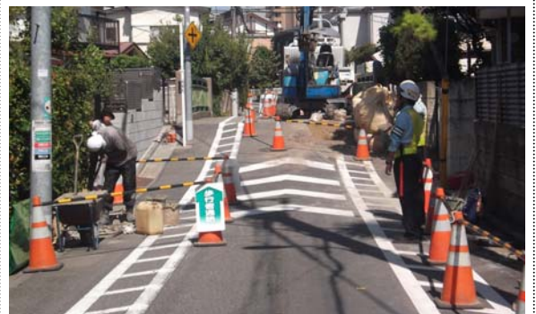
新たな排水ルート設置のための工事が完了
