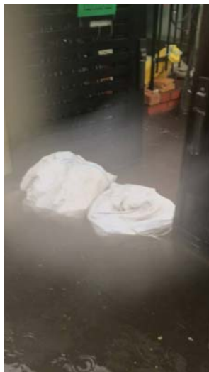
土のうを越える浸水になった。土のうの設置や小型排水ポンプの設置では対処しきれない状況となっている。
