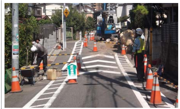
新たな排水ルート設置のための工事が完了
