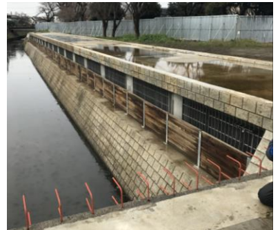
直径60m、深さ27mの調節池内部（上写真） 調節池の取水口と越流堤（右写真）
