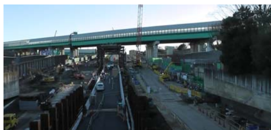
大泉JCT工事現場。外環道工事現場では、死亡事故も含む重大事故が頻発している。
