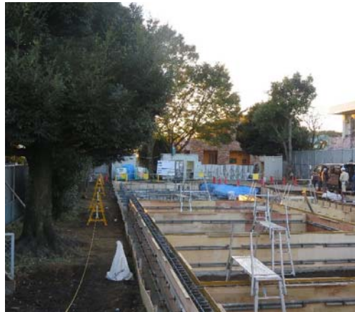
向井公園では、保育所の本工事を着工。
