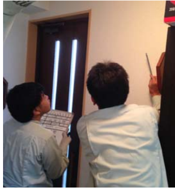
家屋内壁面の調査
