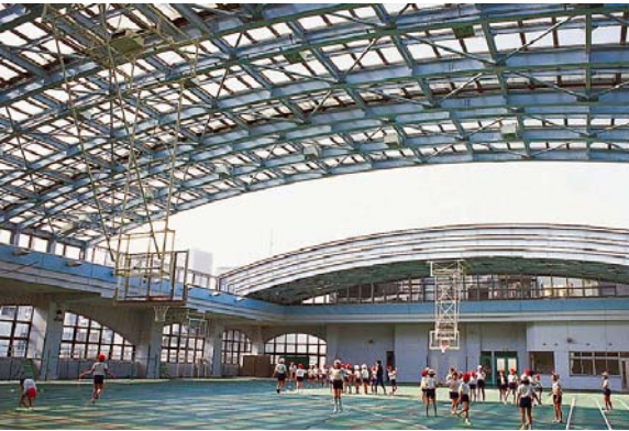
株式会社横川システム建築HP 施工実績「昌平児童館屋上校庭 開閉式ドーム」より
