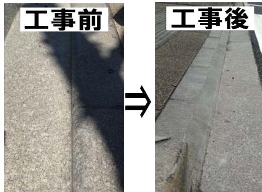
横断歩道の段差部分に2cm程度の高さがあり、車椅子の移動が困難になっていた（左写真）。段差部分に傾斜を付け、段差を解消した。付近一帯も同様の対策を実施（右写真）。
