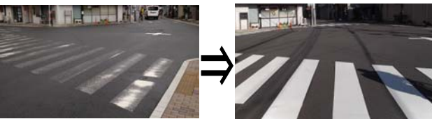
危険な交差点の解消に向け、道路表示等の補修
