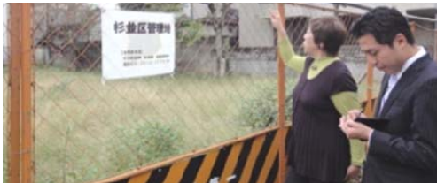
隣接公園の拡張整備工事が始まりました。
