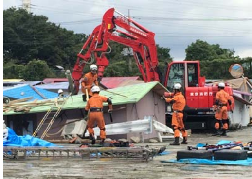
倒壊建物からの救助の様子。日本に2台しかない双腕作業機が出動。
