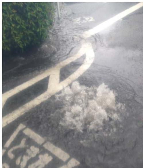
住宅街のマンホールから水が噴き出す。川の氾濫ではなく、窪地の住宅地に周囲の水が流れ込むために発生する浸水被害。
