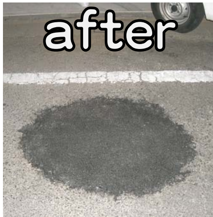
陥没の穴埋め (一例)
